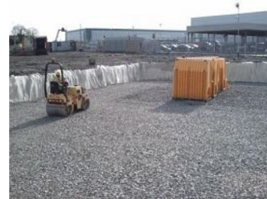
3. Tłuczeń łamany zgęszczamy do min. 95% gęstości standardowej Proctora
