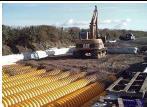
8. Warstwa tłucznia zgodna z projektem, minimum 15 cm
