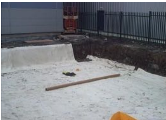
1. Wykonujemy wykop, następnie wykładamy wykop geowłókniną
