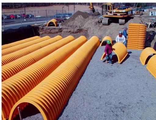
4. Układamy ciągi komór drenazowych (odstęp między rzędami minimum 15 cm)
