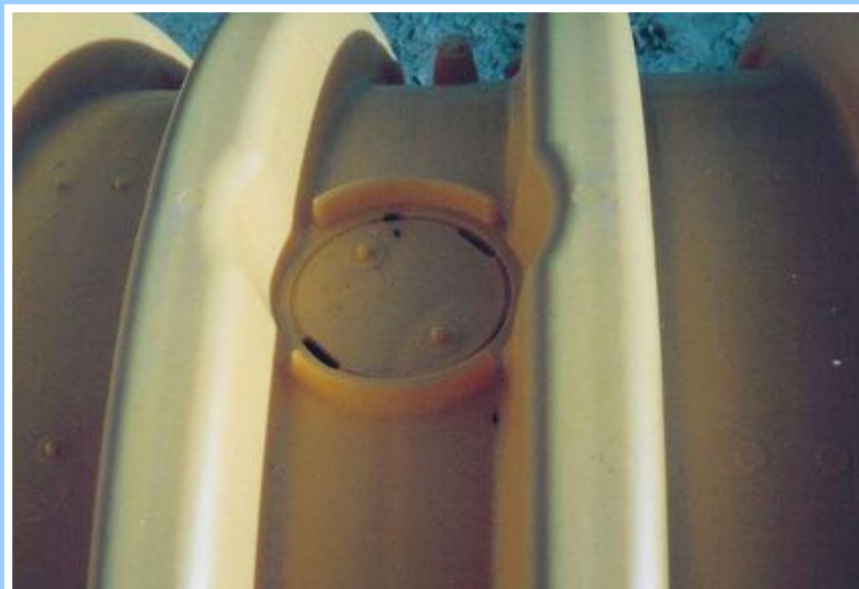
Montaż rury do inspekcji
