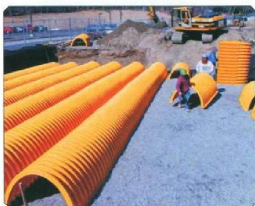
Fot. 3. Montaż systemu komór drenażowych SC.
